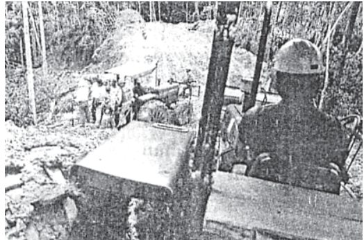
Gambar 04.32 Kerusakan hutan dapat mengakibatkan tanah longsor.
